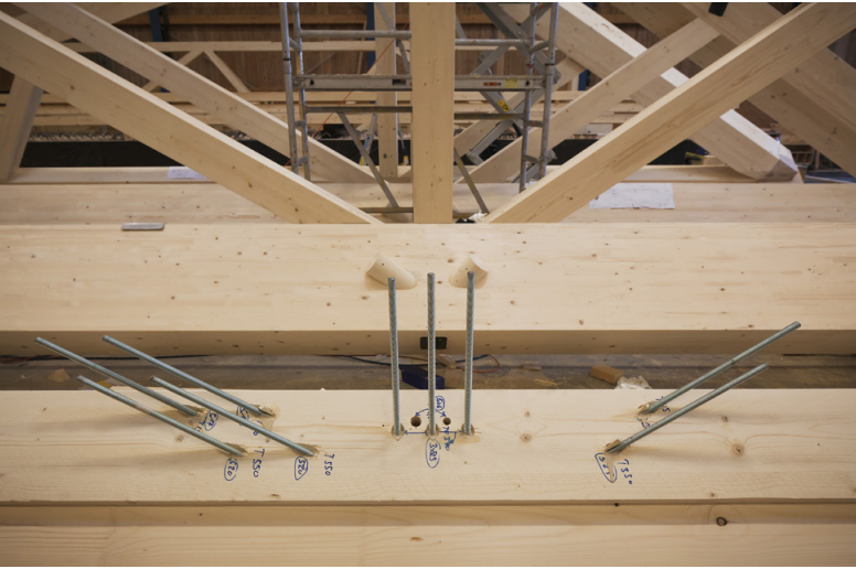
Konstruktionsdetail des Eckknotens von Fachwerk 1 mit Hartholzknoten aus Baubuche
