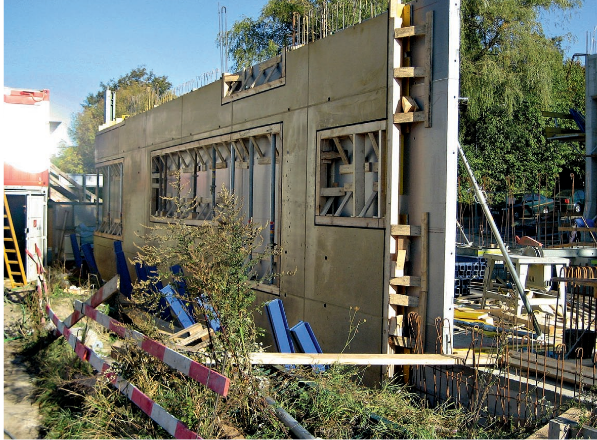
Erster Betonierabschnitt Erdgeschoss Westecke
