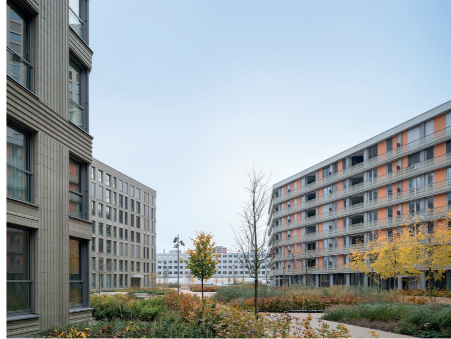
Blick aus dem Hof zwischen Haus B und Haus C in Richtung Pfingstweidpark
