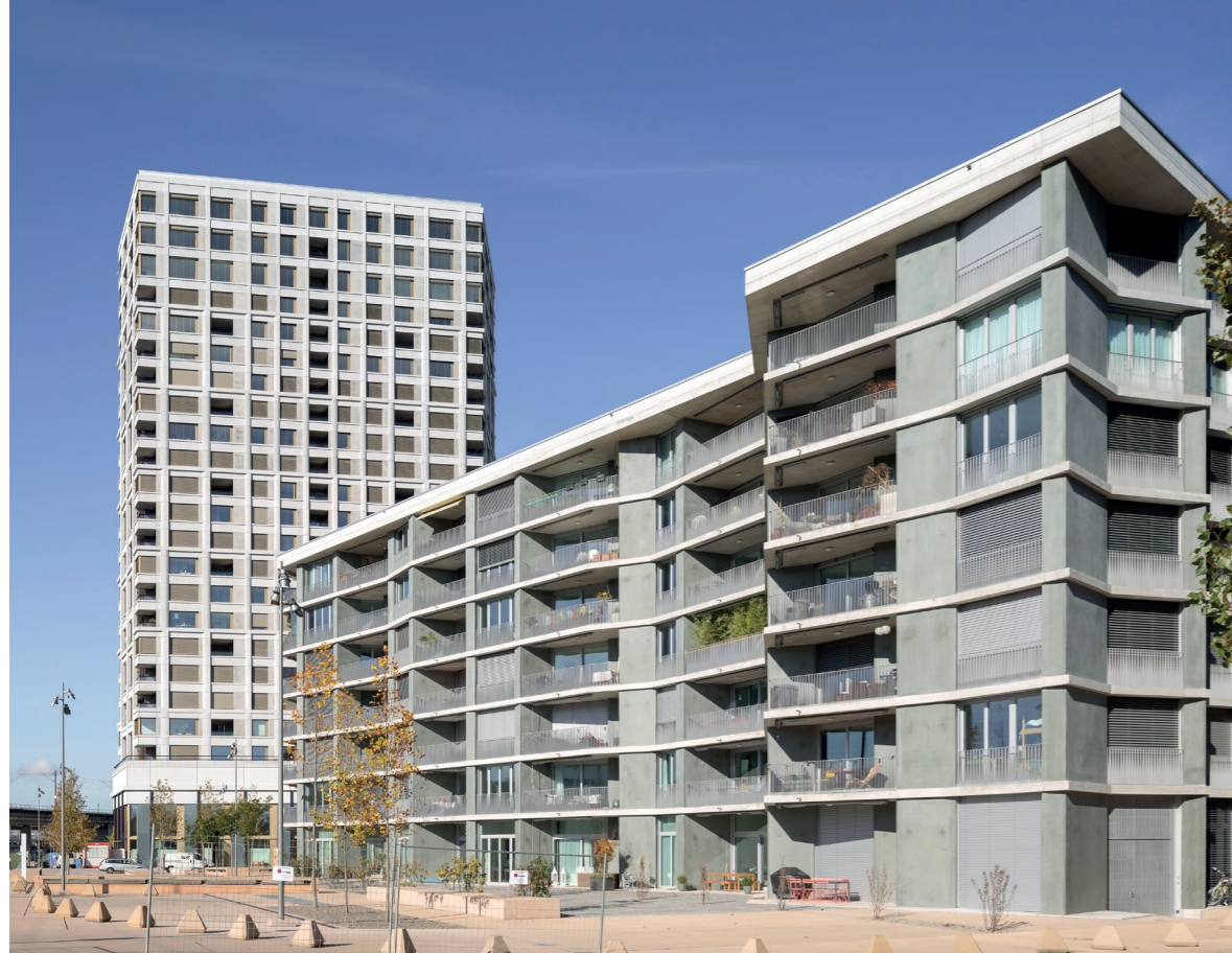
Haus A und Zoelly Hochhaus
