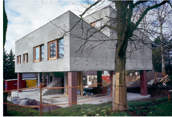
Bauzustand mit tragenden Steinsäulen (Quarzit Wasa)
