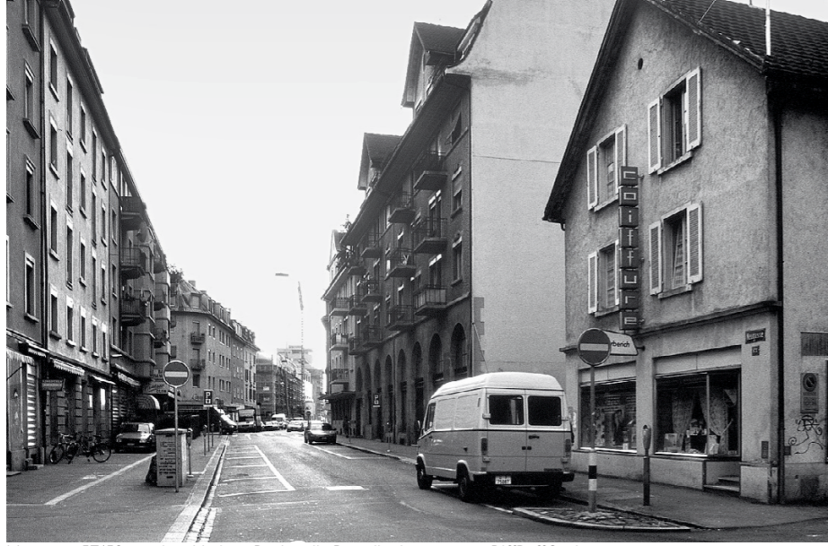
Neugasse 57/59 vor dem Umbau. Rechts die Parzelle des späteren RiffRaff 3+4
