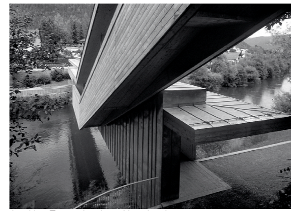
Anschluss Treppenbrücke an Hauptbrücke
