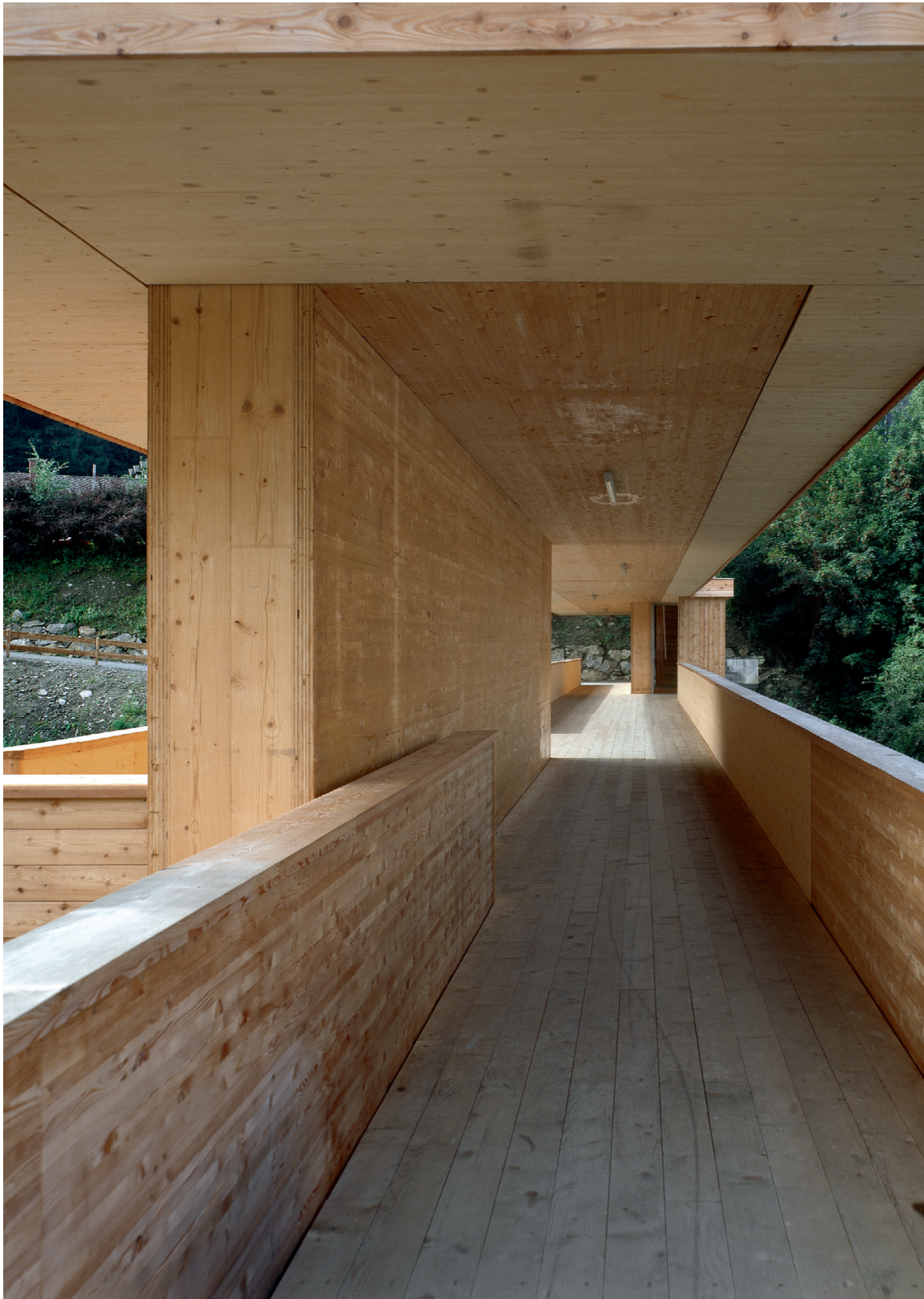
Brückenraum Richtung Bahnhof
