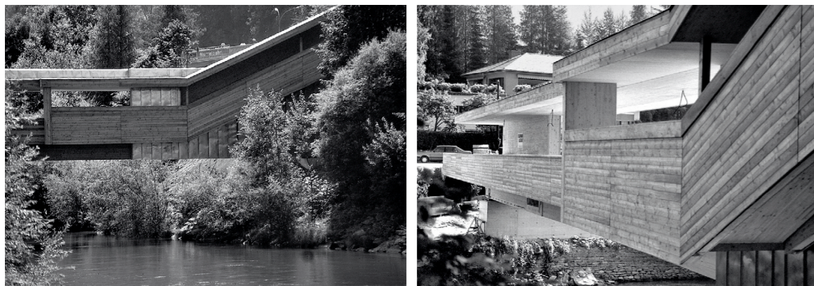
Montageprozess der Brücke im Juli 1995, fertiger Zustand
