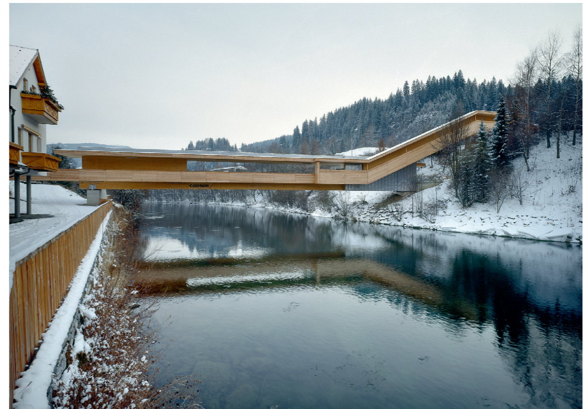
«Fenster» in der Brückenmitte, Ansicht von der Stadtseite
