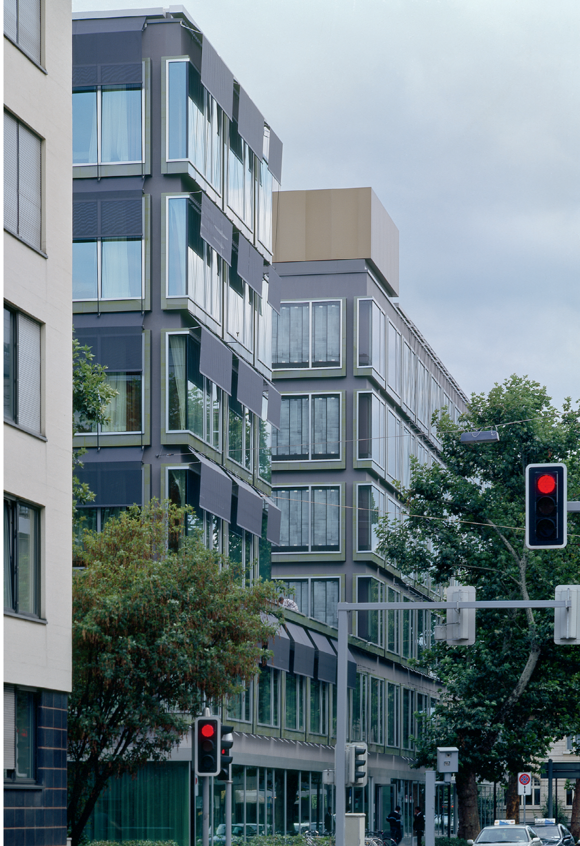
Ansicht Nordwestecke (Stockerstrasse)
