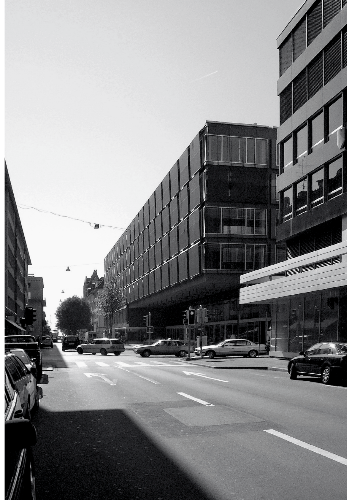
Haupteingang Beethovenstrasse mit Restaurant/Bar
