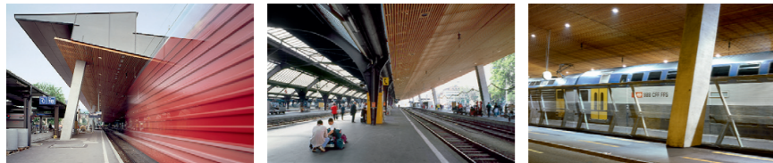
Perrondach Nordseite (Landesmuseum), Perronraum und Nachtabschluss
