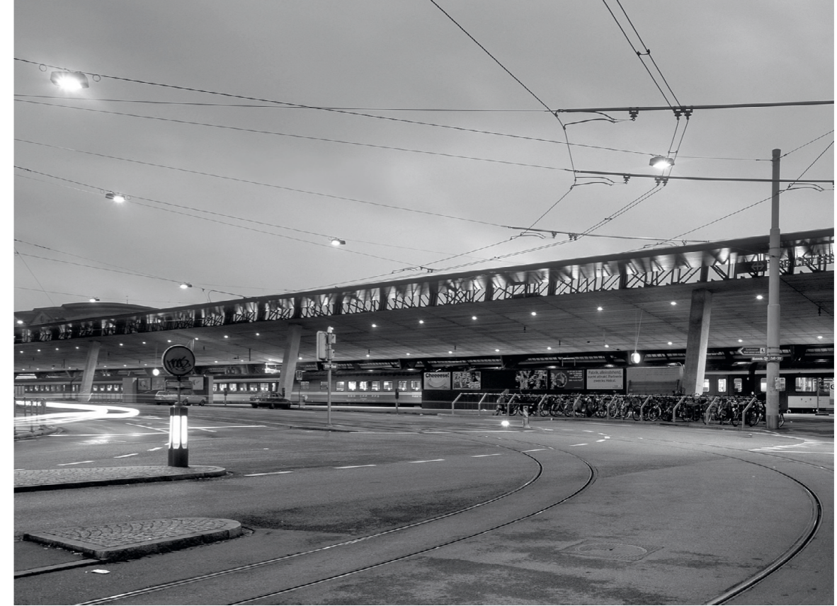
Perrondach, Ansicht von der Sihlbrücke
