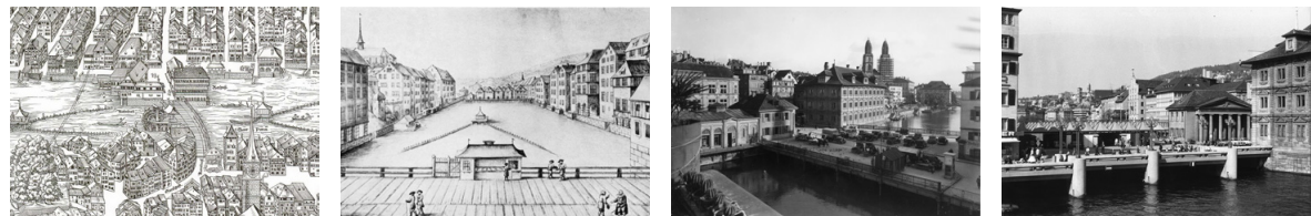
von links nach rechts: Holzbrücke 1576 Holzbrücke 1602 Brücke Tetmajer 1882 Brücke Pauli 1973
