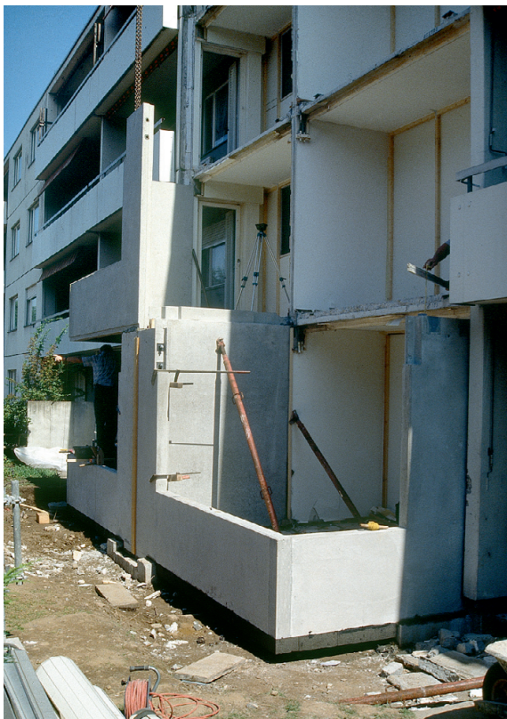
Montage der Südfassadenerweiterung, Konstruktion
