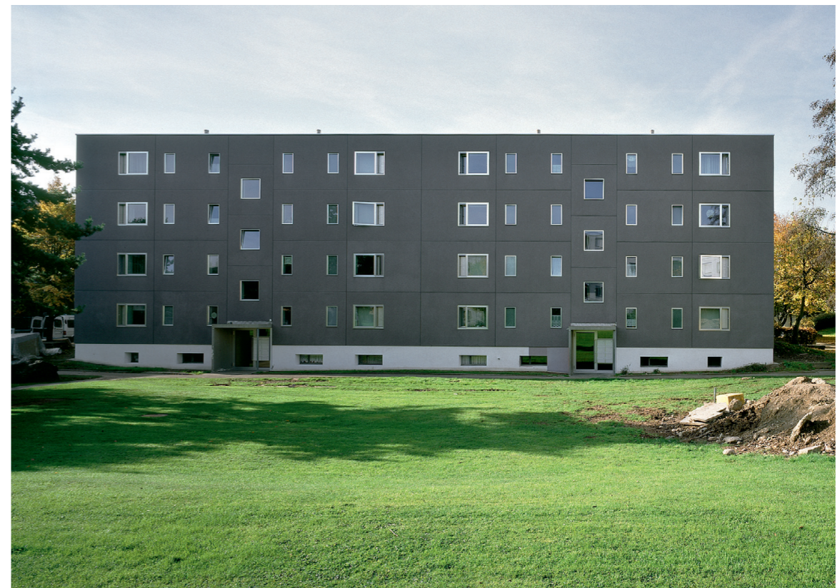
Süd- und Nordfassade nach dem Umbau mit neuem Vorbau
