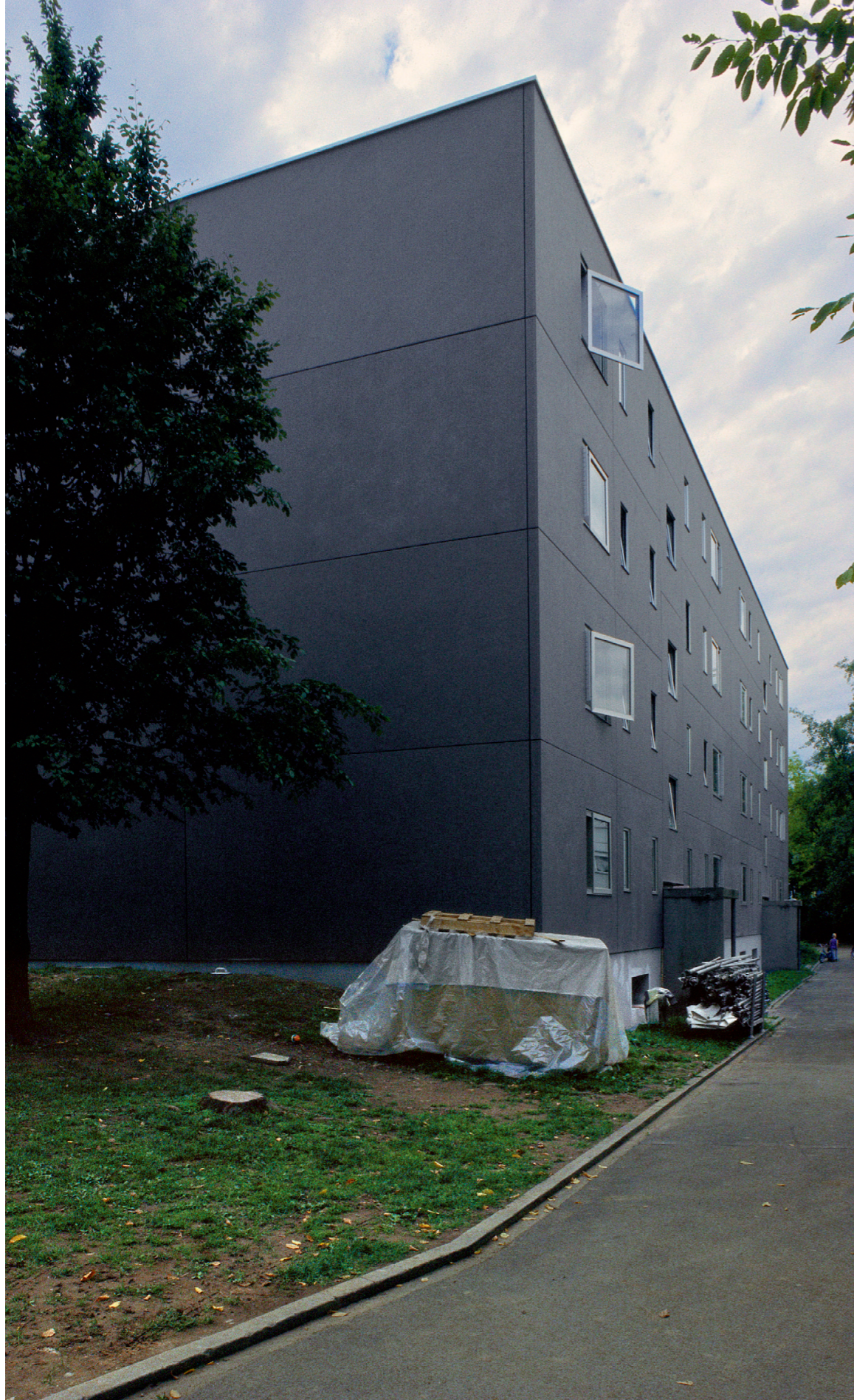
Nordfassade mit ausstellbaren Öffnungsflügeln
