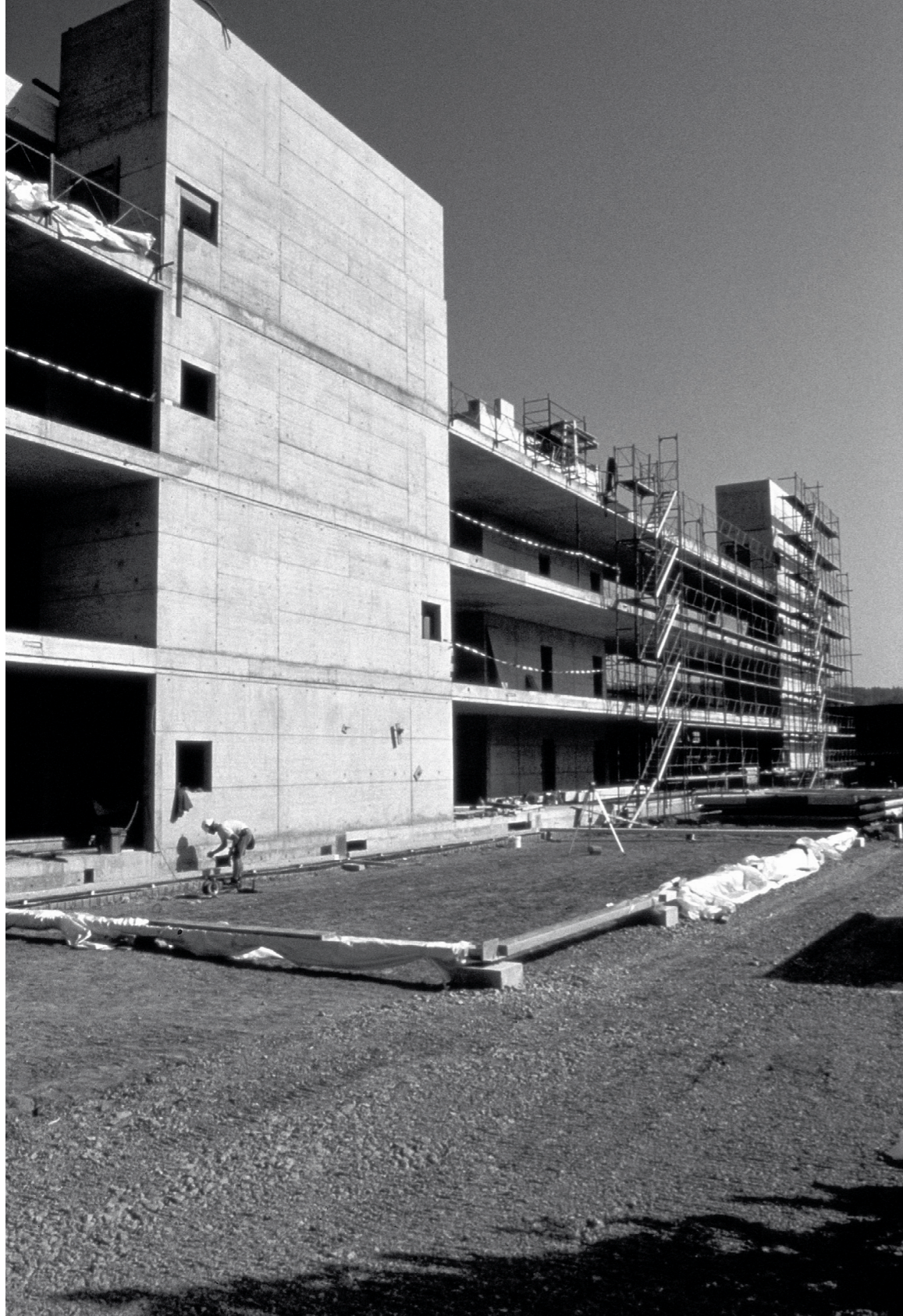
Bauphase des Betonkerns mit Treppentürmen und vorgespannten Geschossplatten
