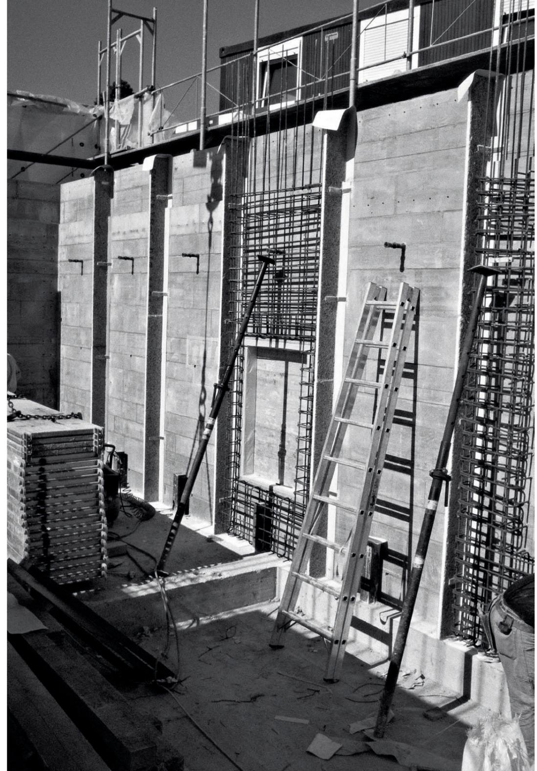
Verbundmauerwerk vor dem Betonieren mit Steinmauer als Schalung und Fugeneinlagen zwischen Betonstreifen
