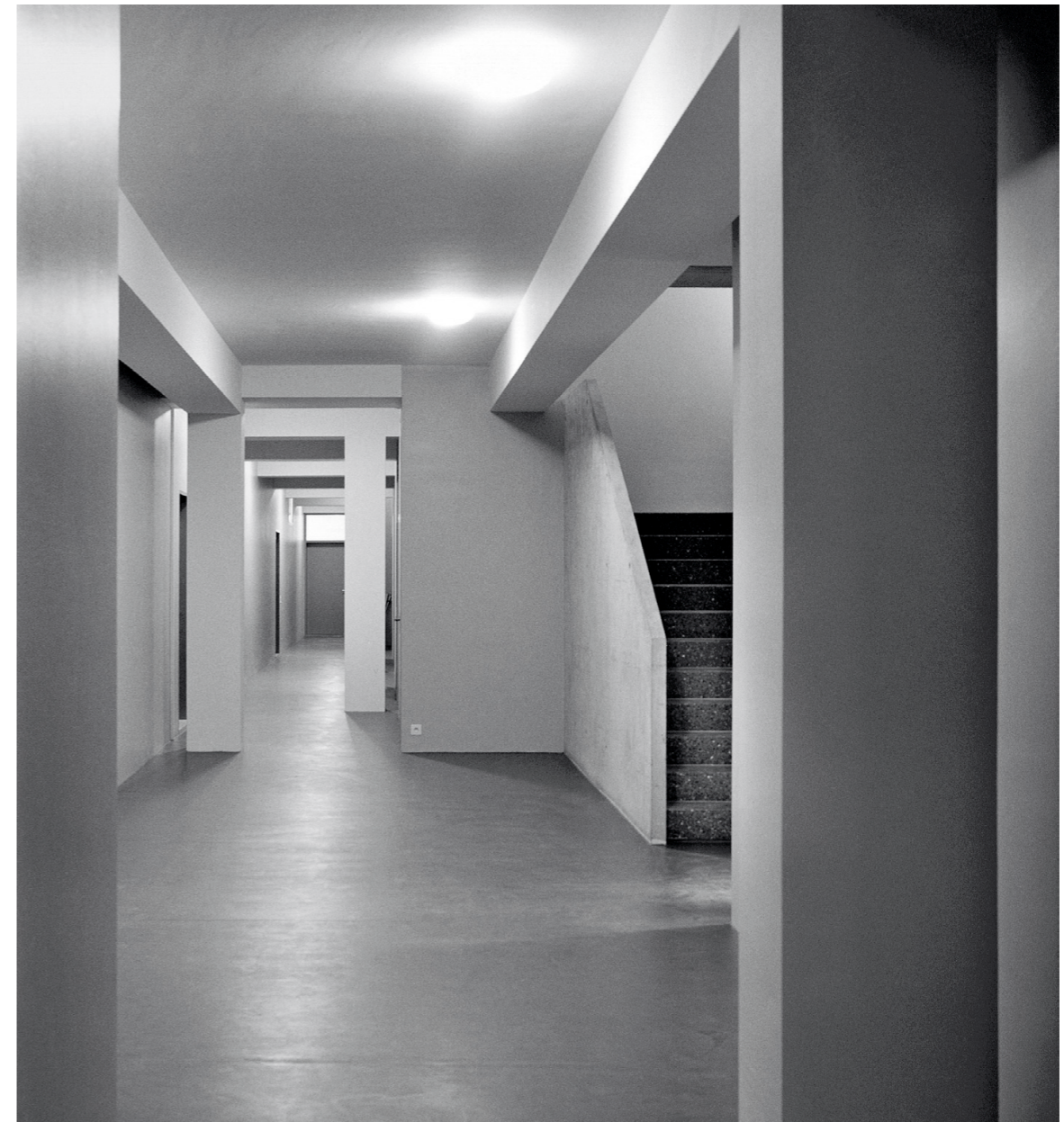
Rue intérieure im 2. Obergeschoss mit Wechsel zwischen Stahl- und Betontragwerk
