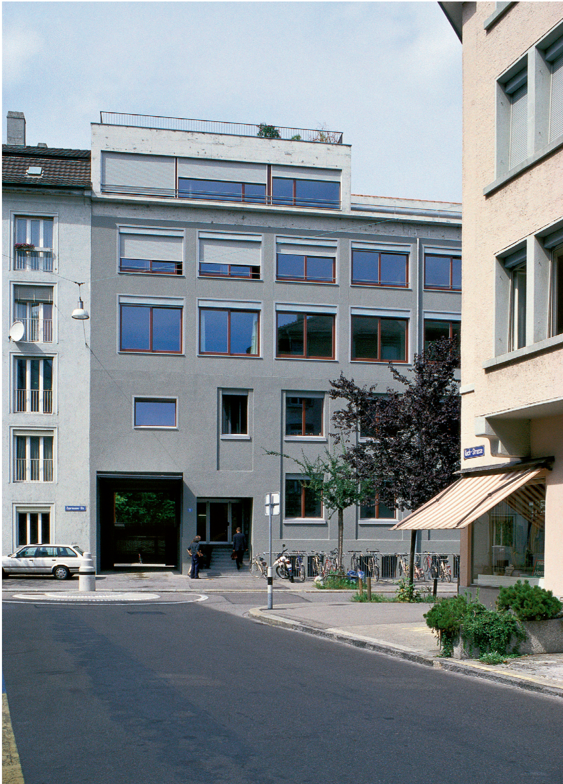
Fassade der alten Teigwarenfabrik (Erdgeschoss/I. Obergeschoss), Aufbau Fünfzigerjahre mit Fensterumbau, neue Dachgaube
